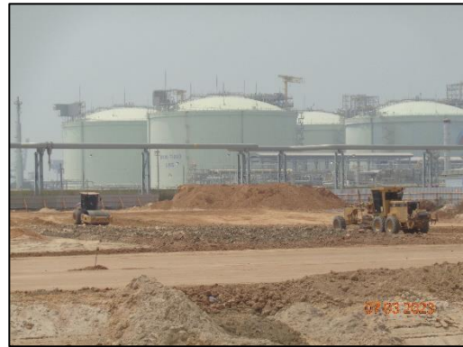
งานปรับสภาพพื้นที่โดยการถมดินและบดอัดดิน
