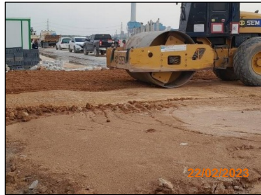
งานปรับปรุงพื้นที่โดยการถมดินและบดอัดดิน
