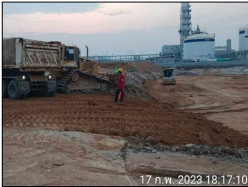
งานปรับปรุงพื้นที่โดยการถมดินและบดอัดดิน
