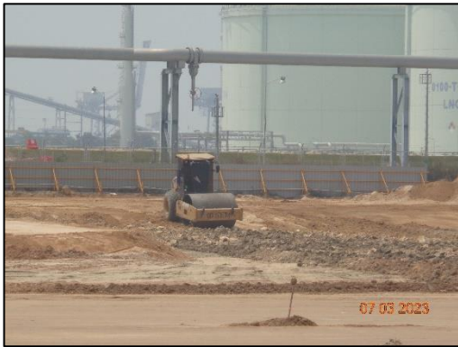
งานปรับสภาพพื้นที่โดยการถมดินและบดอัดดิน
