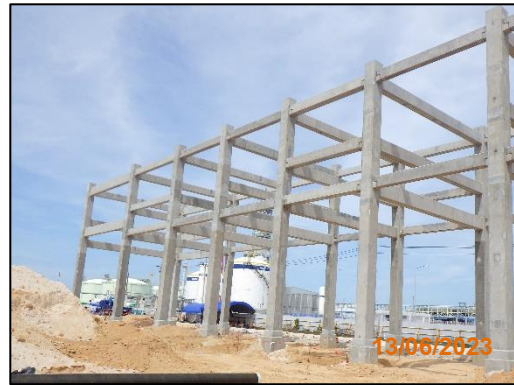
งานโครงสร้างชั้นวางท่อ (Pipe-Rack)
